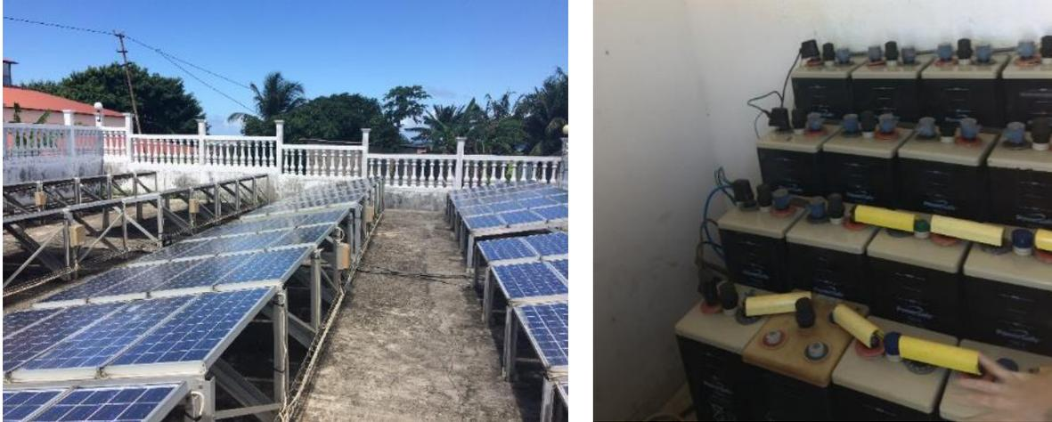
Ilustración 9: Planta FV de GETESA con generador solar (izquierda) y acumulación (derecha)
